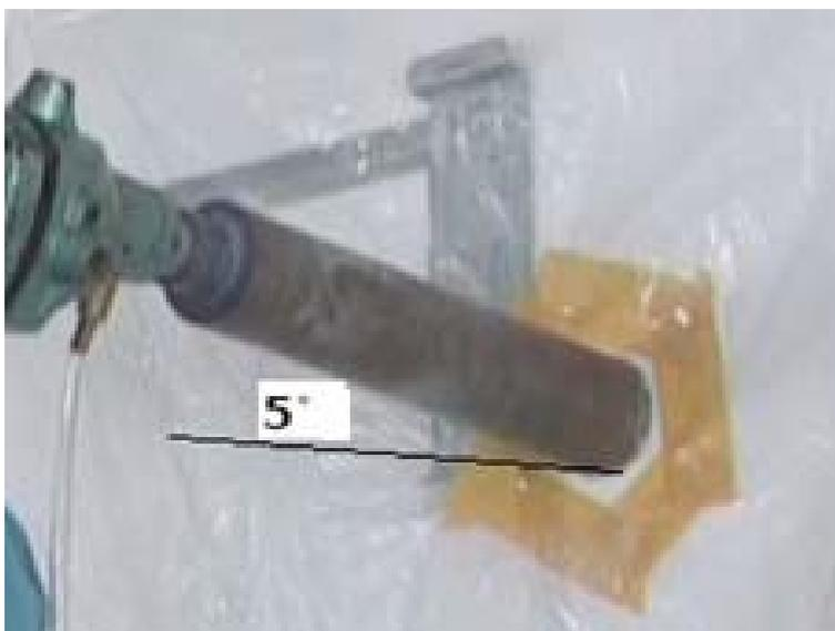
**Примечание:** при сверлении отверстий для крепления трассы трубопроводов внутри помещения следует учитывать прокладку трассы с уклоном 5 градусов в сторону улицы (для беспрепятственного слива дренажа).
